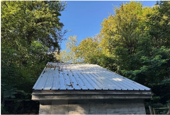
Das neue Dach des Reservoirs
