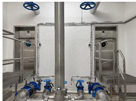
Einbau von zwei Drucktüren
